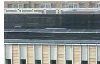
大学間光館屋上(20kwh)
