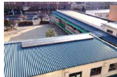
幼稚園舎屋上(4kwh)
